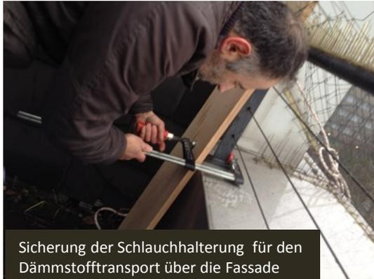
Sicherung der Schlauchhalterung für den Dämmstofftransport über die Fassade
