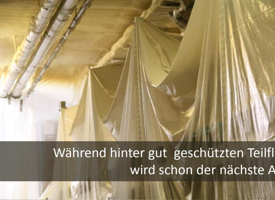
Während hinter gut geschützten Teilflächen die PU Dämmung aufgebracht wird, wird schon der nächste Abschnitt Warenlager versetzt
