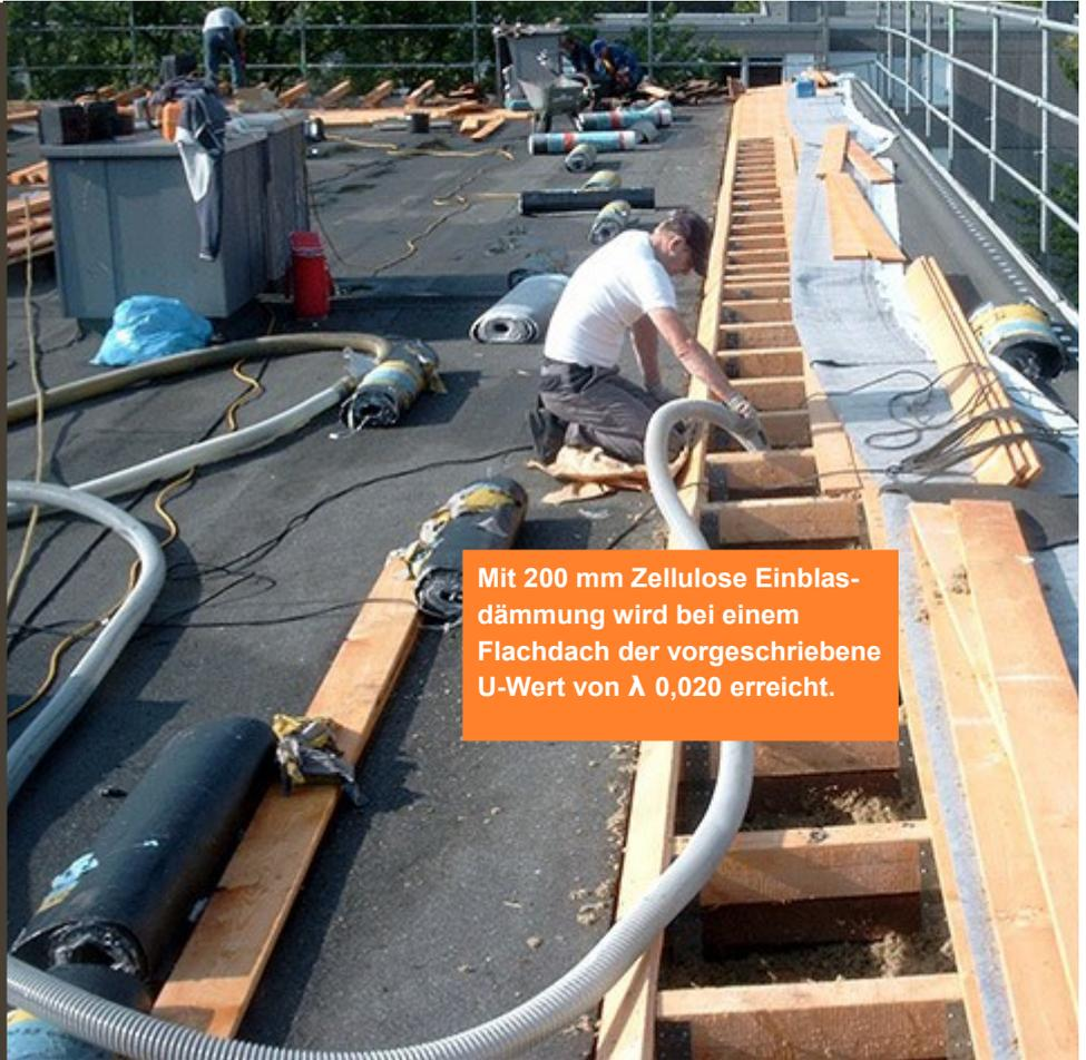
Mit 200 mm Zellulose Einblasdämmung wird bei einem Flachdach der vorgeschriebene U-Wert von  $\lambda$  0,020 erreicht.
