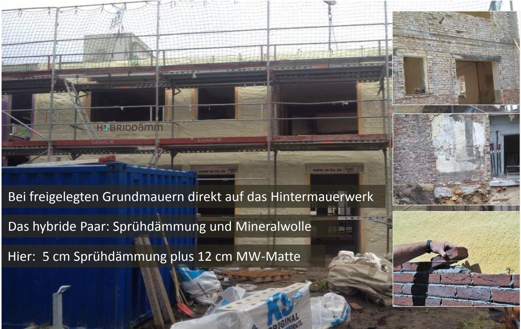
Bei freigelegten Grundmauern direkt auf das Hintermauerwerk
