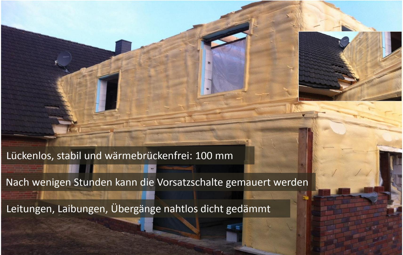
Lückenlos, stabil und wärmebrückenfrei: 100 mm
